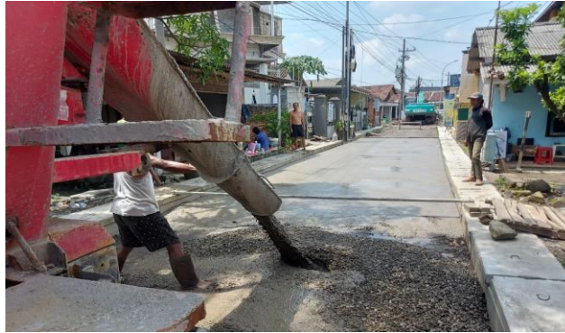
Gambar 2. Proyek Betonisasi Jalan Bringinbendo, Taman, Sidoarjo
