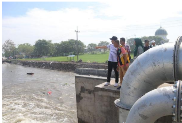
Gambar 4. Proyek Rumah Pompa Kedungpeluk
